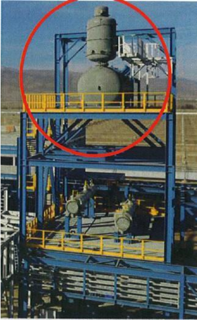
Figura 7.Desgasificador.
