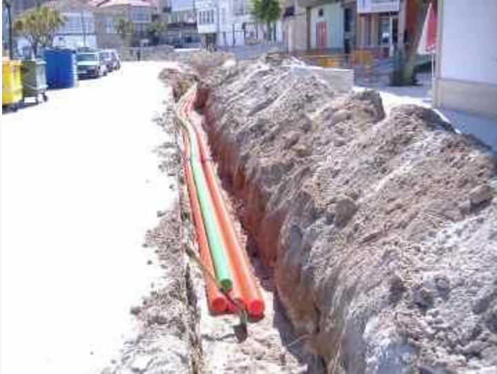
Figura 8. Canalización enterrada.
